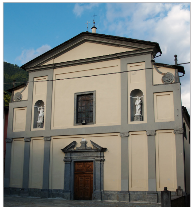
Buglio in Monte, chiesa di San Fedele, facciata (foto: U. Zecca)
